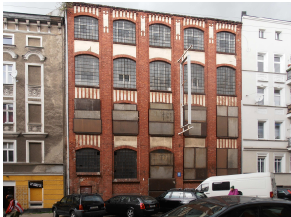
Fot. 7. dawny budynek fabryczny wraz z otoczeniem przy ul. ks. Jana Długosza. 23
